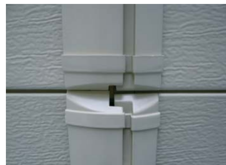
Détail de la protection anti-pince doigt
