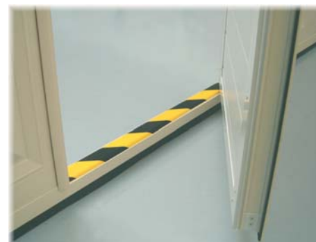
Détail du seuil réduit
