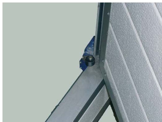
Switch de sécurité du portillon
